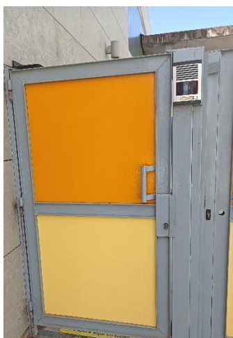
ACCESO PRINCIPAL (PRIMARIA)
